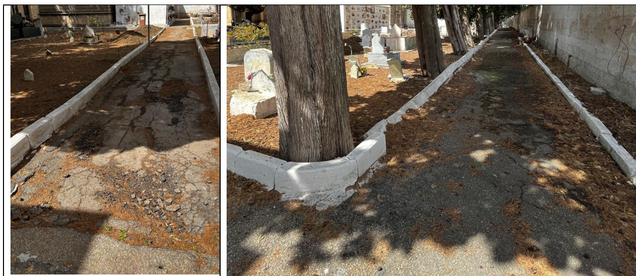
Figura 11-12- Cordoli e alberature attualmente presenti nell'area cimiteriale
