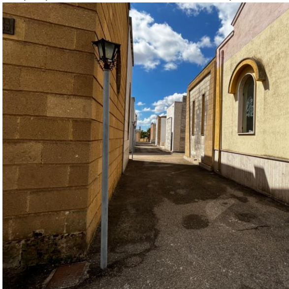
Figura 8- Corpi illuminanti del tipo non funzionanti attualmente presenti nell’area cimiteriale
